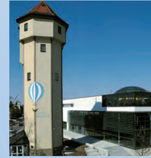
Der alte Gersthofer Wasserturm war die „Keimzelle“ des Ballonmuseums.
